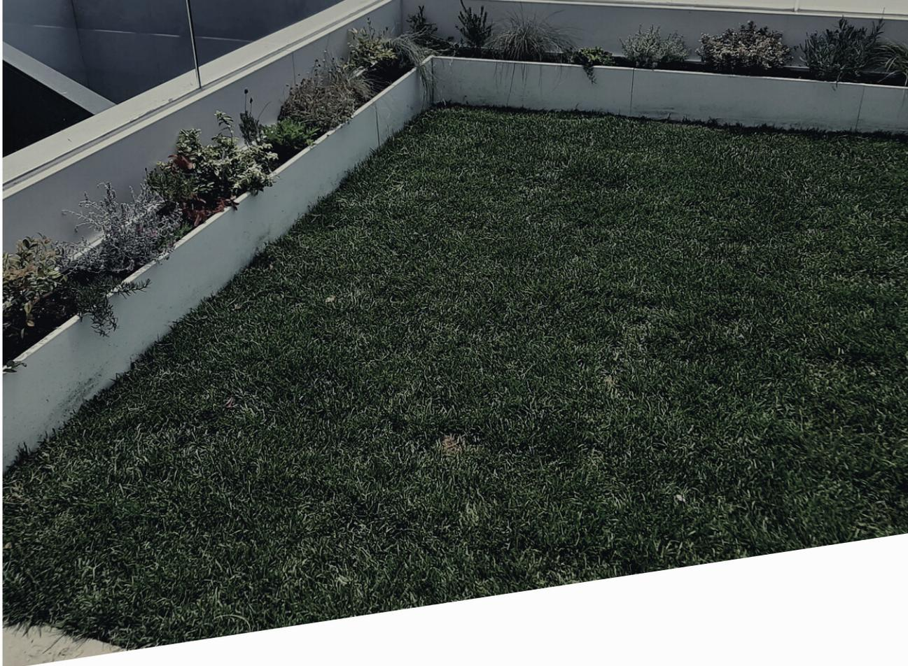
**La cubierta ecosistémica con módulos BIOFIVER® es una revisión del sistema de cubierta aljibe en la que se han modificado algunos elementos para permitir una mejor implantación de la vegetación, permitir la transitabilidad, disminuir el peso por m<sup>2</sup> y, además, funcionar como filtro biológico del aire y del agua.**
